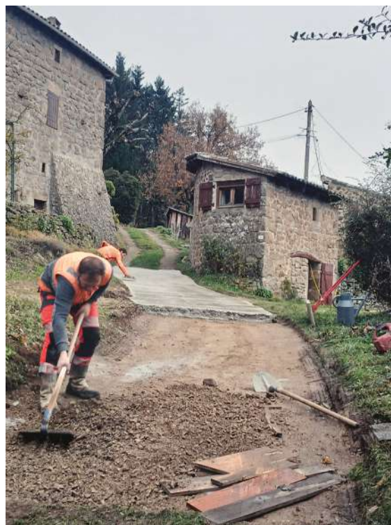
Travaux passage de la Calade (Dounon)
